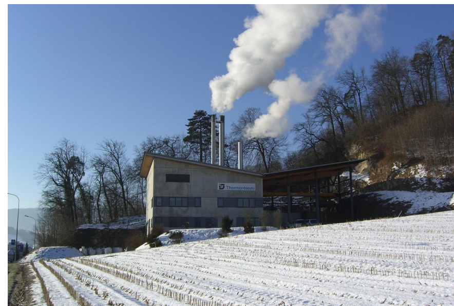
Le chauffage à distance de Porrentruy, mis en service en 1999
