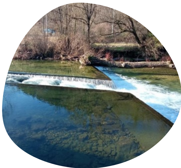
Production hydraulique: Seuil et passe à poisson
