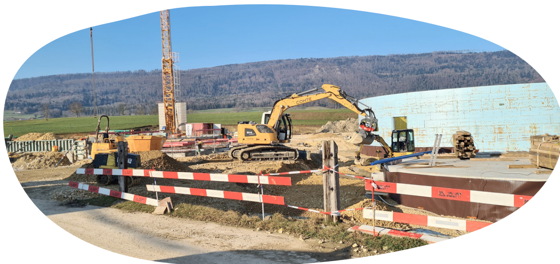
Construction de la centrale de Courtemelon - janvier 2023
