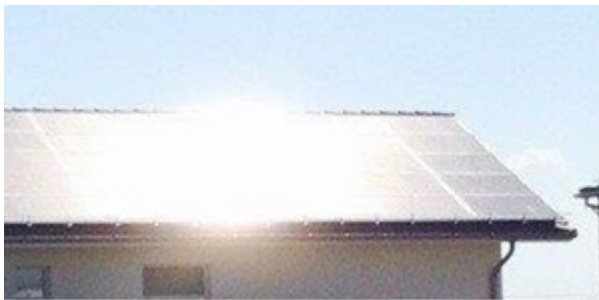
Illustration 7 : Effet d'éblouissement d'un toit en pente. L'élargissement du faisceau est nettement visible, reconnaissable au fait qu'un phénomène lumineux étalé est perceptible au lieu de l'image directe du soleil
