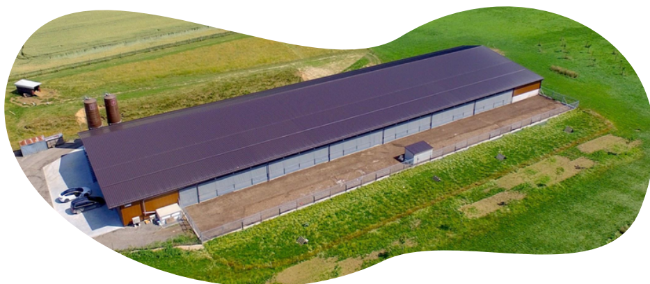
Toit du bâtiment agricole à Bonfol qui accueillera la première installation réalisée dans le cadre du partenariat EDJ-Solarify, la mise en service est prévue début 2023
