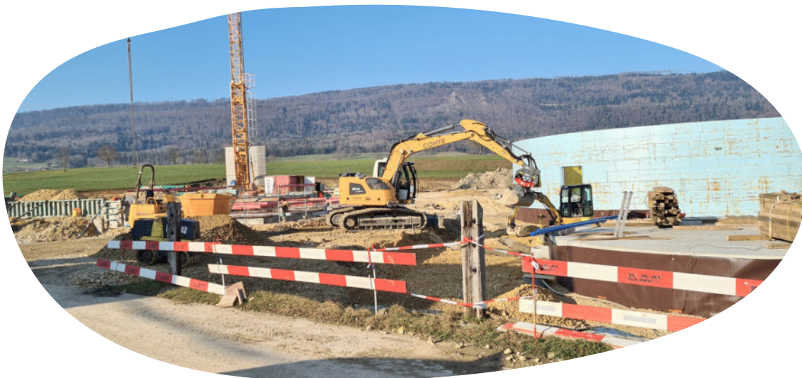
Construction de la centrale de Courtemelon - janvier 2023
