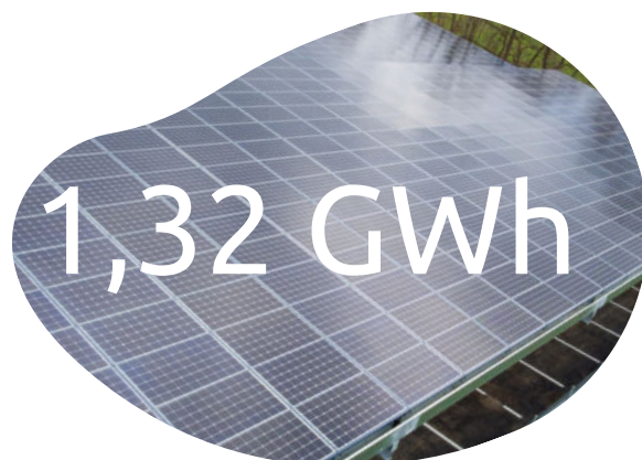
Production des installations photovoltaïques propriétés d'EDJ en 2022-2023, équivalent à la consommation en électricité de 330 ménages
