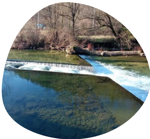
Production hydraulique: Seuil et passe à poisson
