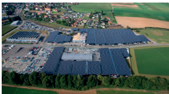
Installation photovoltaïque GEFCO à Courgenay
