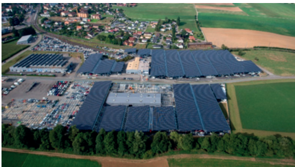
Installation photovoltaïque GEFCO à Courgenay
